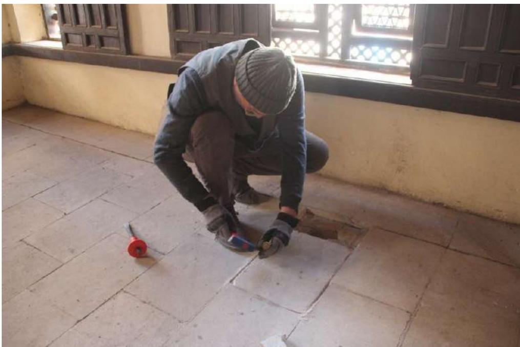
Fig. 12 Sondaggio nel pavimento del primo piano
