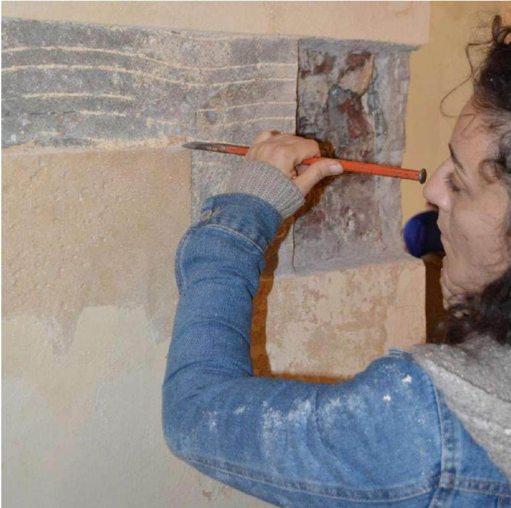
Fig. 11 Esecuzione del sondaggio stratigrafico
