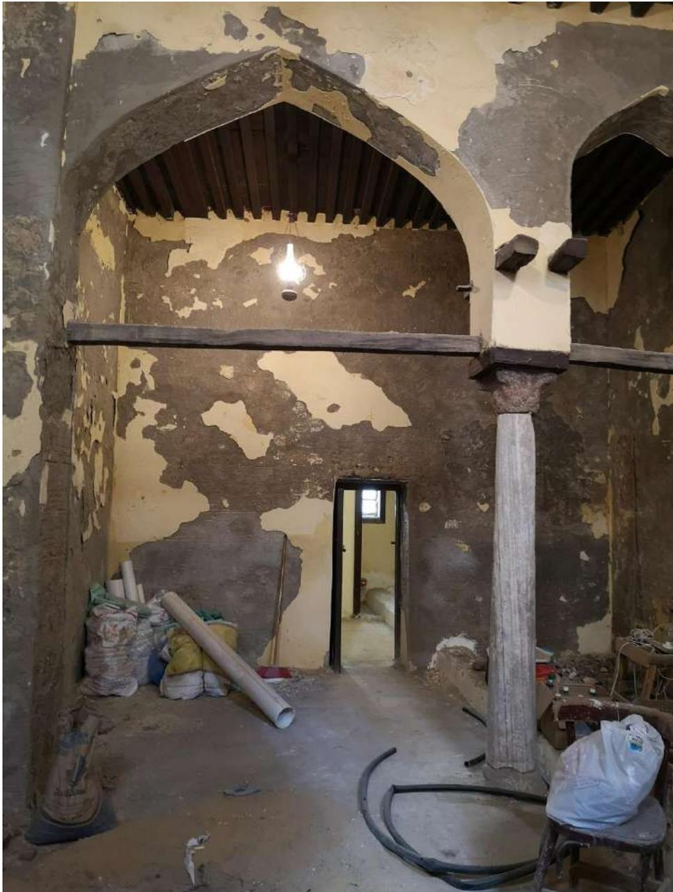
Fig. 5 Casa Amasili, piano terra, elementi del degrado
