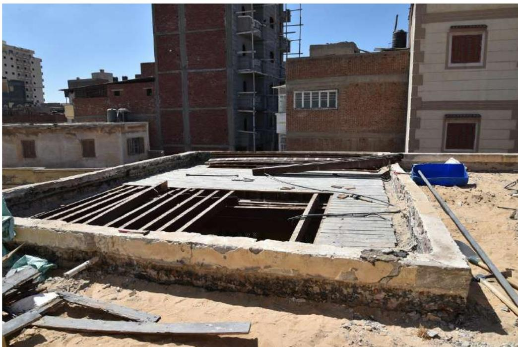
Fig. 19 Rimozione delle travi di legno consumate
