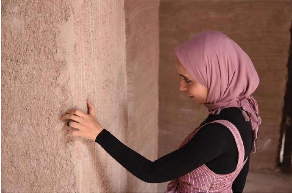
Fig. 27 Ispettrice al controllo della consistenza del nuovo intonaco grezzo di fondo dopo la fase di asciugatura
