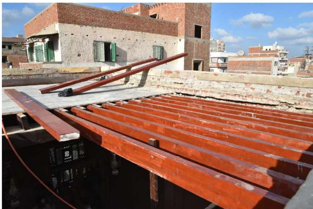
Fig. 20 Installazione delle nuovi travi di legno
