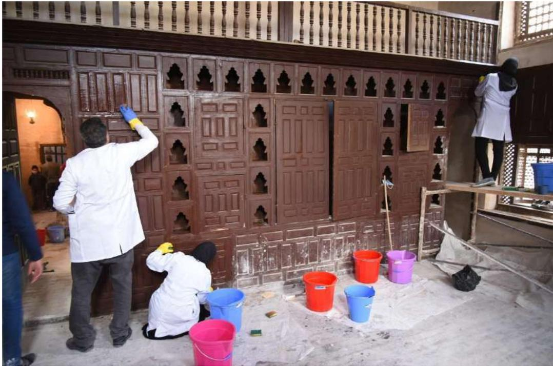
Fig. 29 Pulitura della struttura in legno
