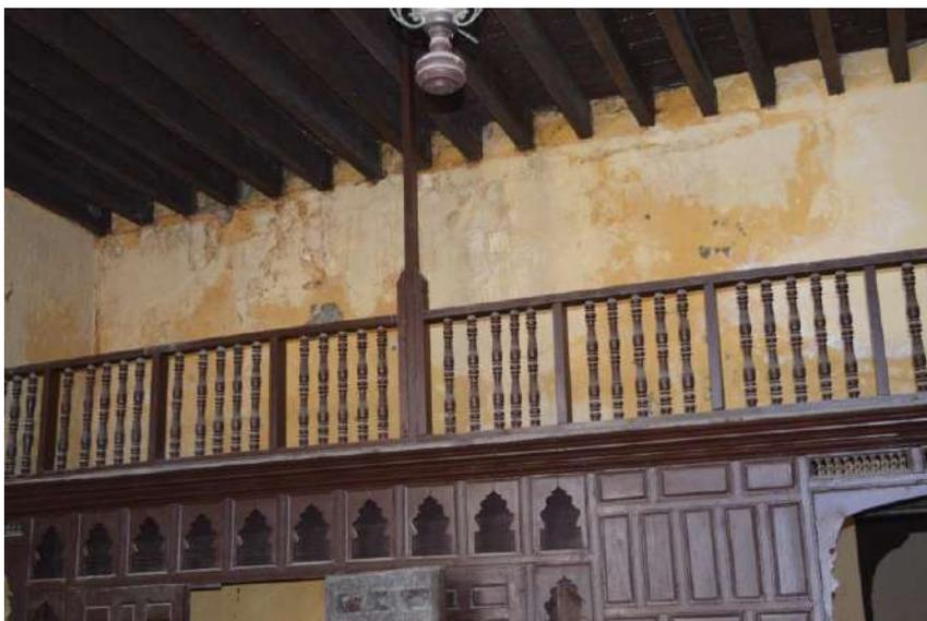
Figg. 6-8 Infiltrazione dell'acqua piovana dal tetto al secondo piano
