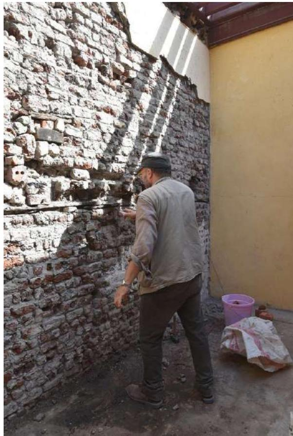
Fig. 24 Vista del muro più danneggiato al secondo piano e realizzazione del consolidamento
